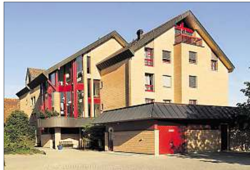
Vom Armenhaus zum Altersheim: Das Doppelhaus mit den markanten Dächern wurde 1990 eingeweiht und diente als Vorlage für das neue Logo. (Jean-Claude Stuck)
